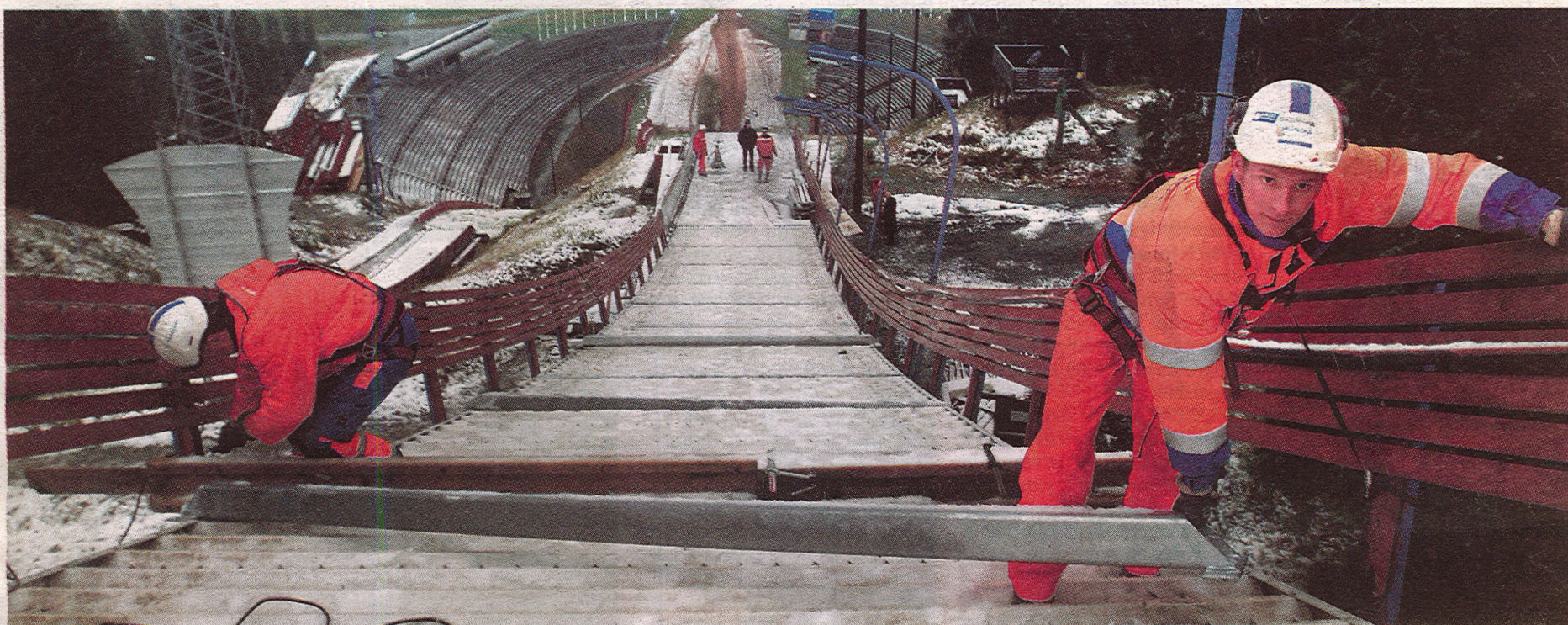
Står på Dragan Andjelic (t.v.) og Andreas Vagnild fra Skanska monterer stålbjelker i tilløpet som forberedelse for verdens mest moderne og høyteknologiske tilløp. Foto: JENS SØRAA
