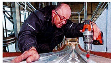
Wolfgang Riedel, der Onkel des Geschäftsführers, ist mit dem Einbau der Anlaufspur beschäftigt.
