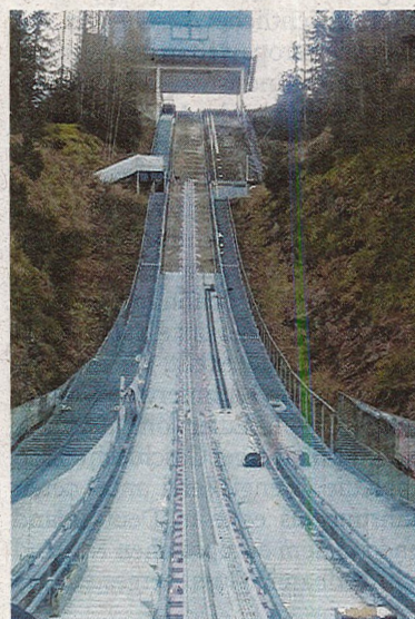
Der noch im Umbau befindliche Anlauf vom Schanzentisch aus ...
