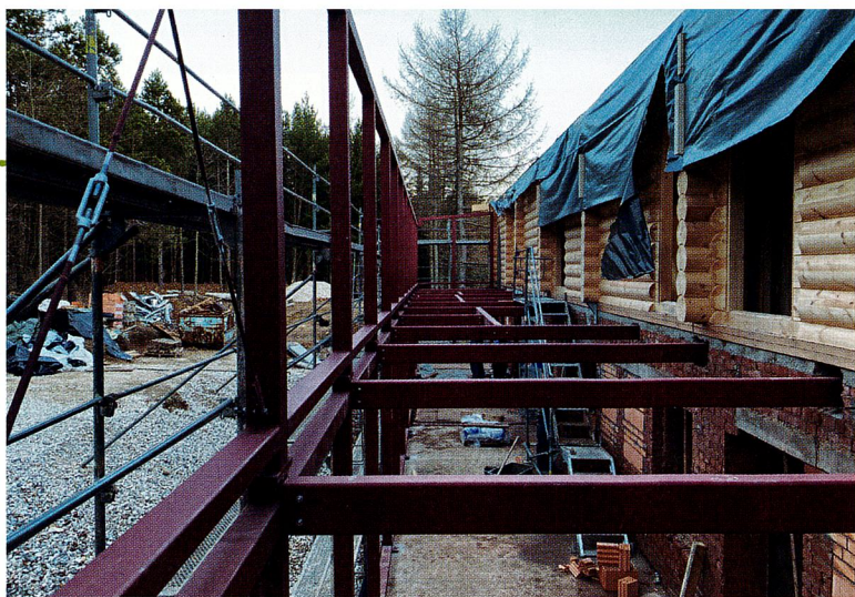
Für den Glasanbau sowie für den Zugang vom Jens-Weißflog-Hotel hat Peter Riedel Stahlkonstruktionen gefertigt.
