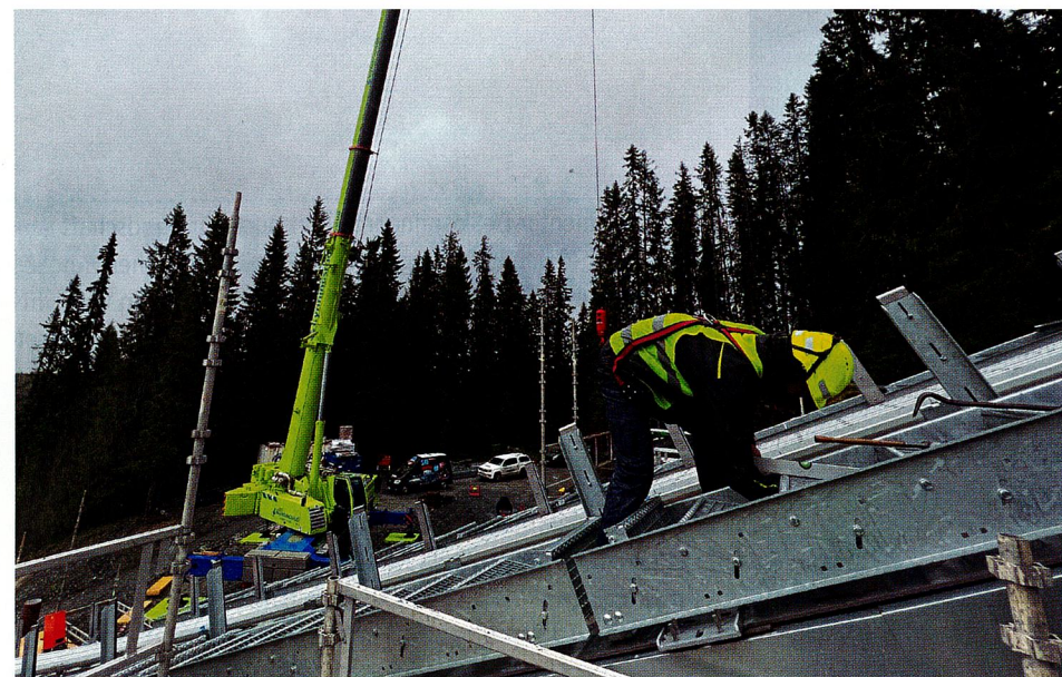
Treppenelemente werden links und rechts vom Anlauf montiert. Die Schanze hat eine Anlaufhöhe von 93,13 Metern. Auf ihr werden 2025 die Nordischen Skiweltmeisterschaften ausgetragen werden.
